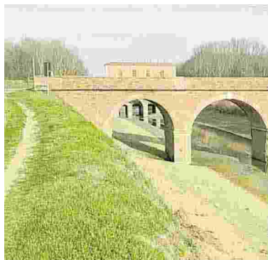
Il ponte di strada Menadizza
