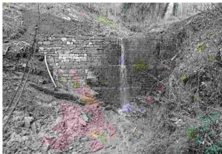
Messo in sicurezza l'abitato vicino al fosso del Chiasso
