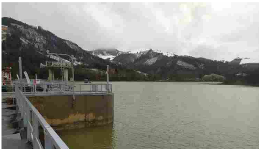
Immagine della diga di Mercatale pubblicata dal Consorzio di Bonifica
