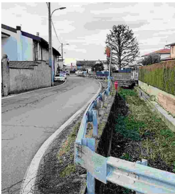
Via Marconi a Misano Gera d'Adda dove sarà realizzata la ciclabile
