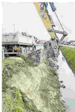
I lavori sullo scolo Mestrina
