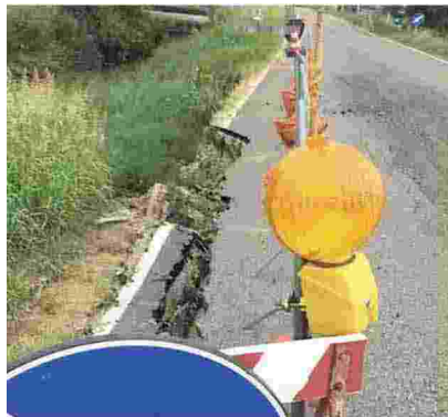
Il tratto di via della Parata, tra Filo a San Biagio, interessato dal cedimento. La strada è importante per la circolazione dei mezzi agricoli
