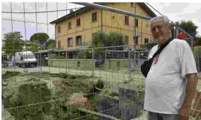
Il residente Veris Fiamenghi e la voragine nei del condominio in cui abita (Salieri)
