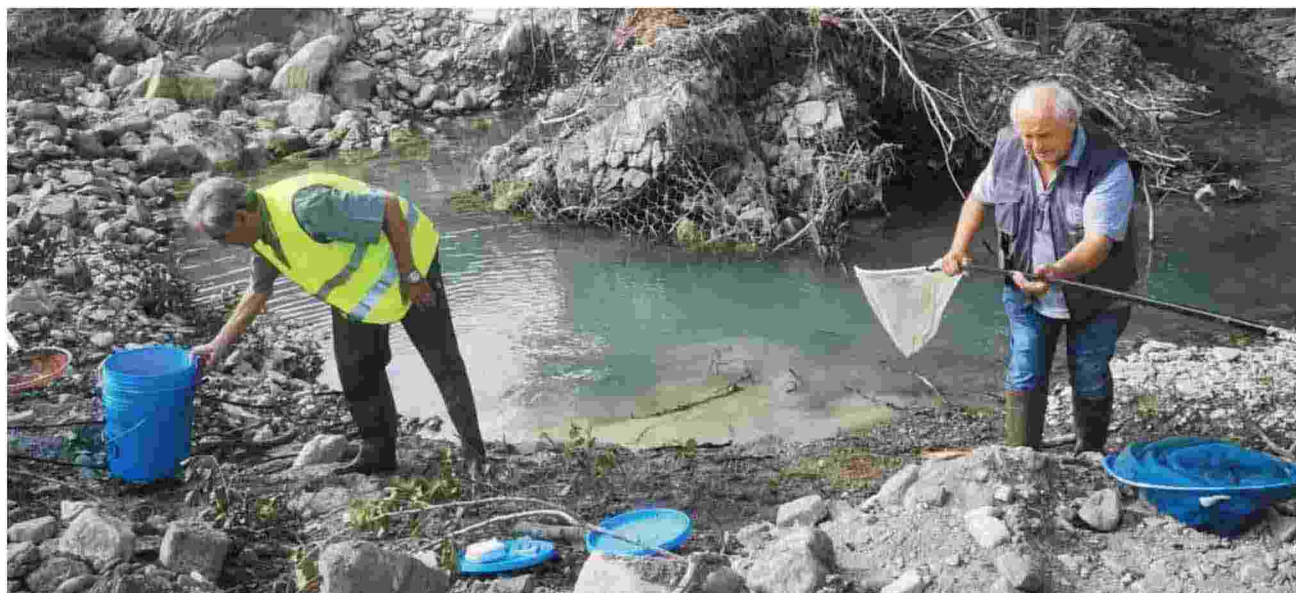
Fauna ittica da salvare Arriva il cantiere per la sistemazione del fiume nel territorio di Pieve Santo Stefano e Fipsas si è messa al lavoro
