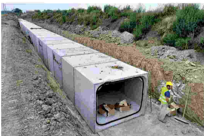
Scatolari posati in prossimità dell'impianto Rovere situato nel Comune di Caorso.
