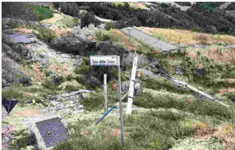
Uno dei devastanti smottamenti sul monte Trebbio e, nella foto piccola, il sindaco di Modigliana mentre mostra una grossa frana all'assessore regionale Irene Priolo
