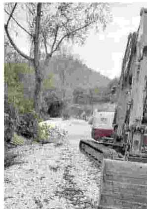
Il cantiere sul Cinisco del Consorzio di Bonifica
