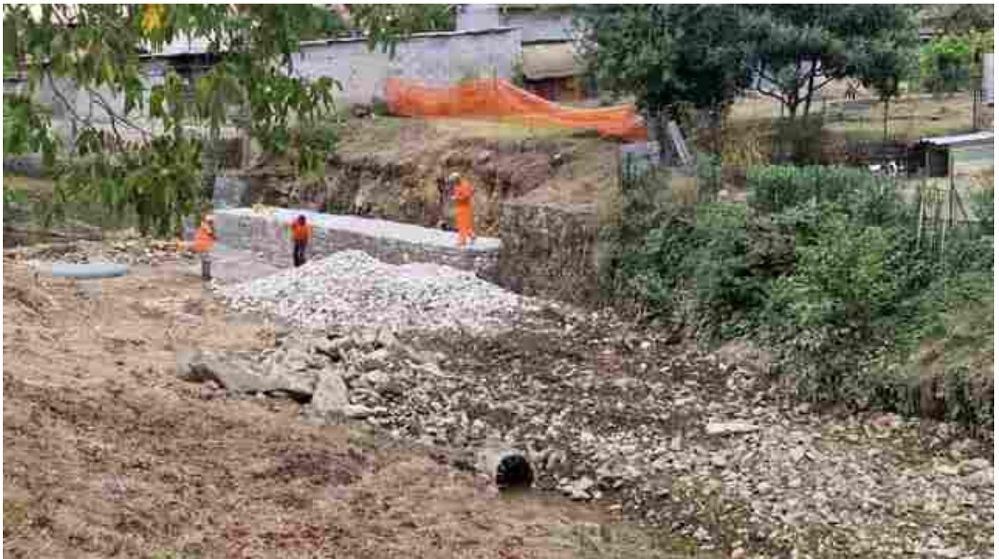
Una complicata operazione di ripristino della sicurezza idraulica nel torrente Chiassa è quasi volta al termine. Si è trattato di opere di riposizionamento della gabbia metallica della sponda per una lunghezza di 15 metri. Il consorzio di Bonifica sta ultimando i lavori dopo aver trovato una situazione di partenza abbastanza compromessa. Il paese è spesso stato soggetto ad alluvioni che hanno interessato il centro della frazione del Comune di Arezzo.
