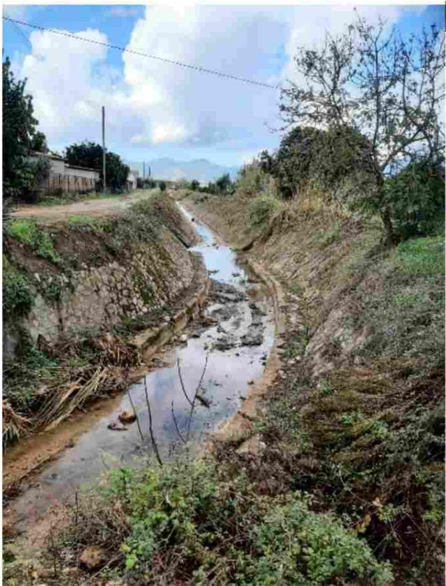
Il Consorzio di Bonifica Lazio Sud Ovest prosegue, senza sosta, i lavori sui canali del suo comprensorio. Sono stati recentemente ultimati gli interventi di trinciatura della vegetazione, di profilatura delle sponde e di riescavo dell'alveo sul fosso Quarto del Casale e sull'Affluente destro del Fosso Moscarello nel Comune di Latina. Stesse operazioni di manutenzione anche sul Fosso Vaccarella che attraversa i comuni di Cisterna e Sermoneta.
