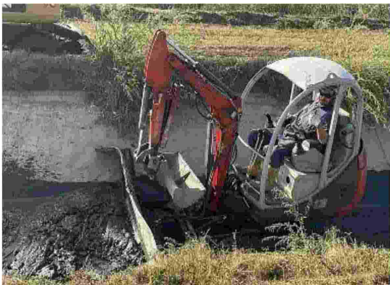
Stilato l'elenco dei lavori per ripristinare gli argini tra Bondeno e Vigarano
