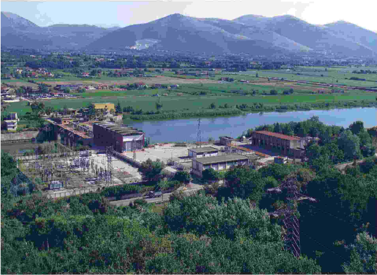
La Diga Traversa di Ponte Annibale sul fiume Volturno. In basso: Francesco Todisco, commissario straordinario del Consorzio Generale di Bonifica del Bacino Inferiore del Volturno e un'immagine dei Regi Lagni
