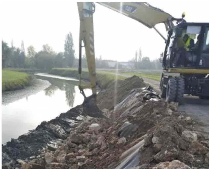
L'escavatore del Consorzio di Bonifica al lavoro per sistemare le frane
