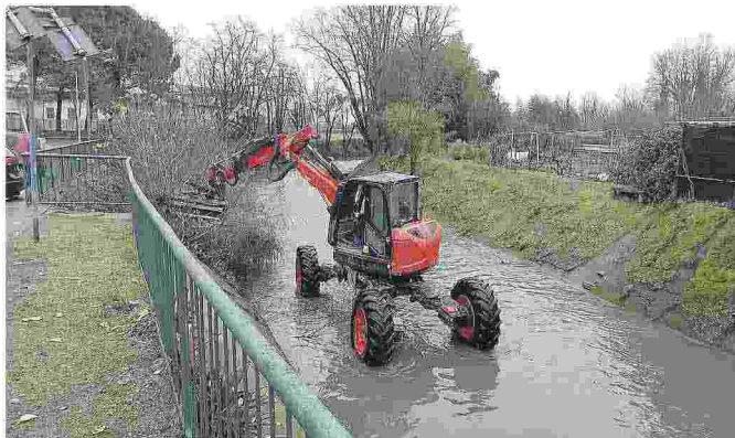
Lavori di pulizia lungo il canale Brembiolo
