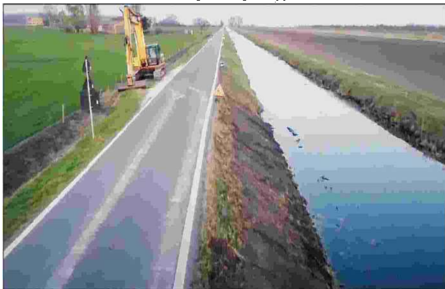
Al via il cantiere per la risistemazione di via Scolo Tron
