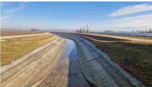
L'intervento assicura, secondo l'ANBI, un incremento del 20% nell'efficienza del Canale, la cui portata sarà pari a 60 metri cubi al secondo
