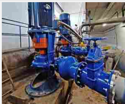
Tarquinia - Pompe lotto V e lotto VI
