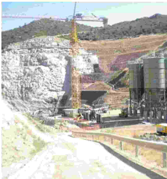
I lavori nella diga di Cumbidanovu in territorio di Orgosolo
