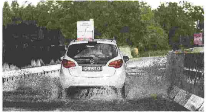
CANTIERI BLOCCATI L'enorme massa d'acqua scaricata a terra nei giorni scorsi ha invaso anche i cantieri di allargamento dell'autostrada A4 nel tratto compreso tra San Donà e Portogruaro
