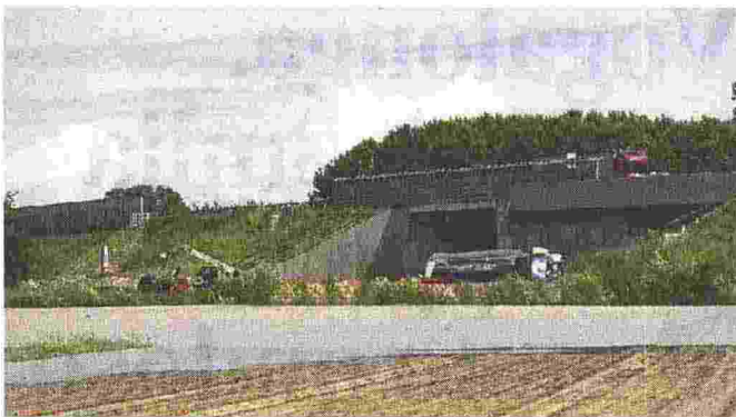
IL RITORNO DELL'EMERGENZA Da martedì è previsto l'arrivo di una nuova perturbazione: nella zona di Portovecchio l'area dei cantieri per la terza corsia dell'A4 è ancora a rischio
