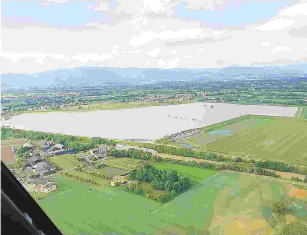
Il bacino di laminazione di Caldogno sul Bacchiglione, allagato nei giorni scorsi
