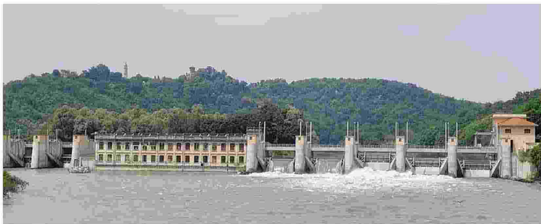
A sinistra: Il complesso dell'impianto
