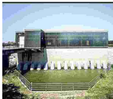
Finocchito Il ripartitore che regola i flussi tra Aqp e impianti irrigui. Nella foto piccola, un impianto dei Consorzi
