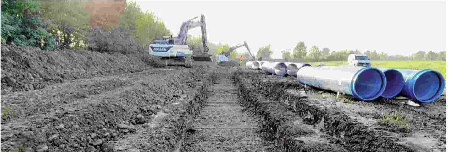
I lavori per la posa delle tubazioni dell'impianto di irrigazione di precisione 4.0, il primo in Lombardia finanziato dal Piano di sviluppo rurale nazionale 2014-2020
