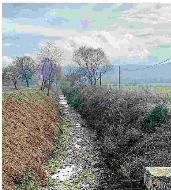
Il Rosia La manutenzione effettuata sul torrente riguarda solo una sponda come da prescrizione regionale. Insieme a Serpenna e Rigo coprono 150 chilometri quadrati
