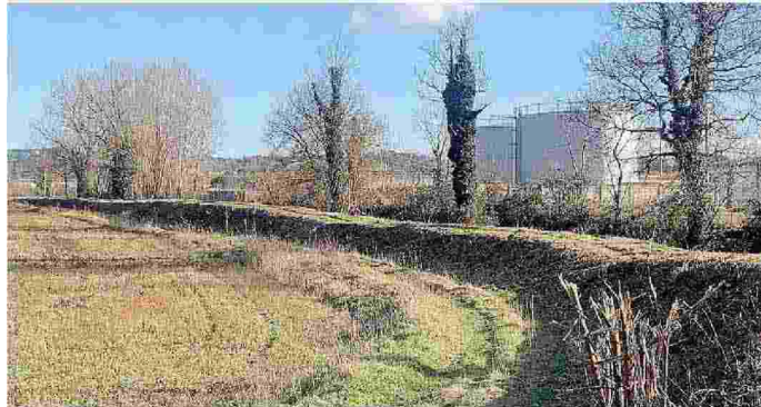
Il lavoro L'opera di manutenzione ordinaria attuata su un tratto del torrente Rigo 3, a Sovicille
