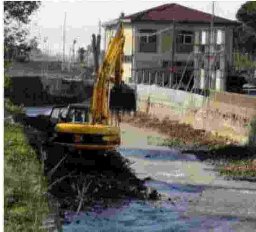
Si è concluso nei giorni scorsi il cantiere da 1,4 milioni di euro sul bacino del Parmignola (foto di archivio)
