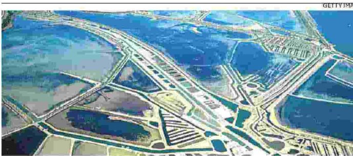
Il delta del Po. Quest'anno si concluderanno vari cantieri nell'area
