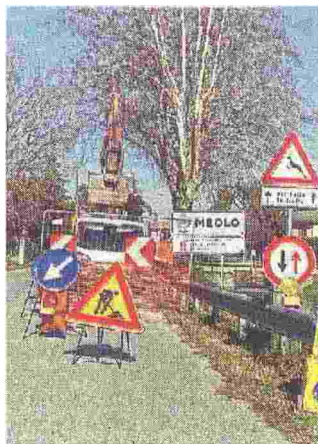
VIA SAN FILIPPO I lavori in corso
