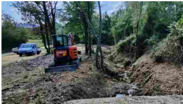
Lavori sui torrenti valdarnesi
