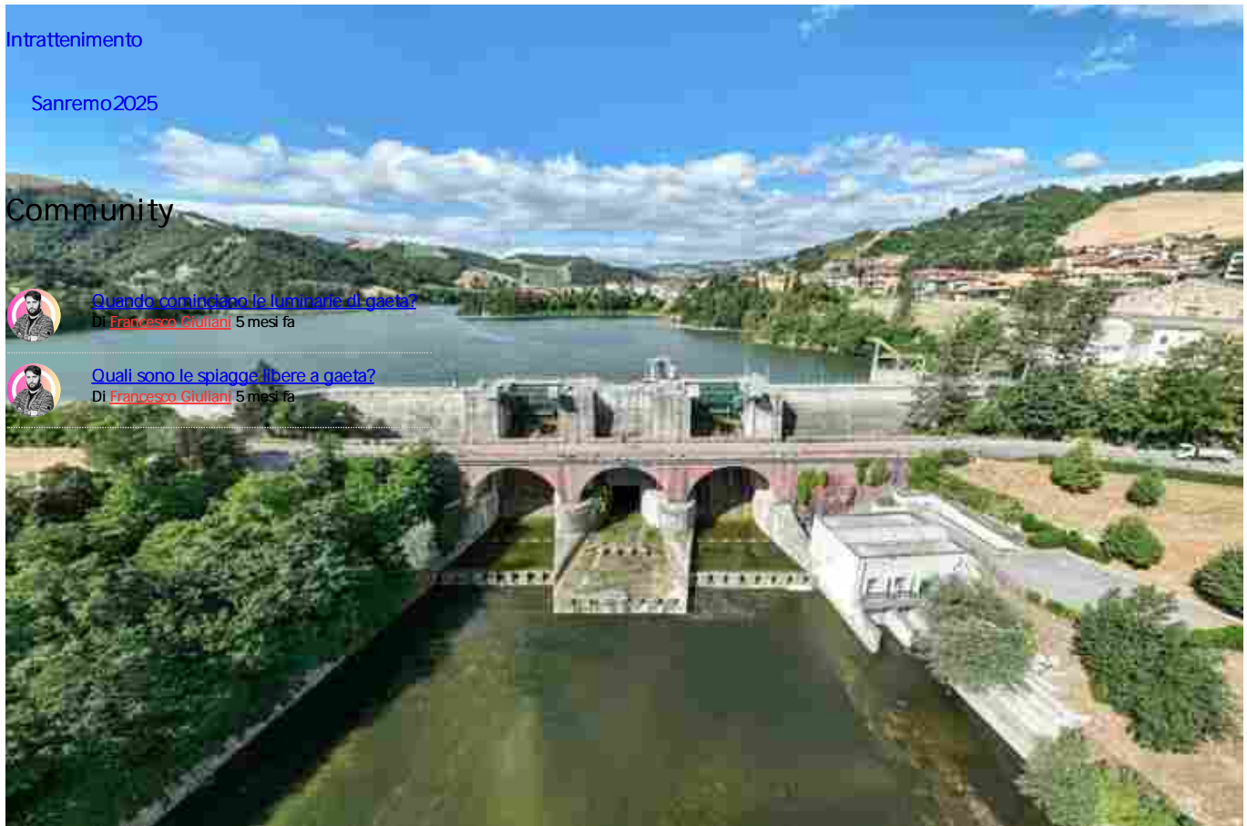
Diga di Mercatale, il Consorzio di Bonifica rassicura: "Nessun pericolo, lavori in corso" Gaeta.it
