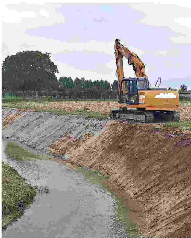
Il cantiere servirà al recupero delle acque tra Cartura e Terrassa
