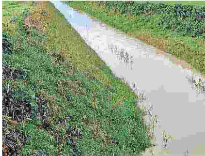
Il lavoro Controlli costanti sui corsi d'acqua
