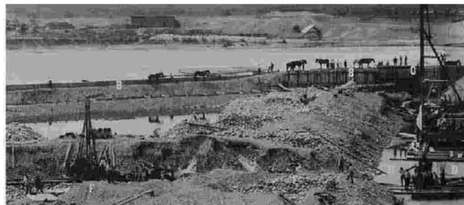
Cavalli e chiatte Nei cantieri della fine dell'Ottocento, gran parte della forza lavoro era fornita essenzialmente da buoi ed equini, mentre i mezzi di trasporto più utilizzati erano grosse chiatte
