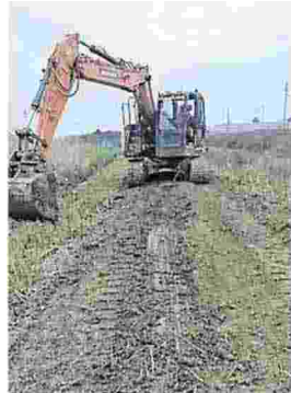
I lavori sui fossi
