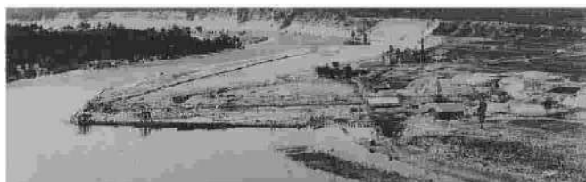
Un capolavoro d'ingegneria Il progetto di Eugenio Villoresi era visionario: costruire una rete di canali di irrigazione che si estendesse dal Ticino fino all'Adda, utilizzando l'acqua del lago Maggiore
