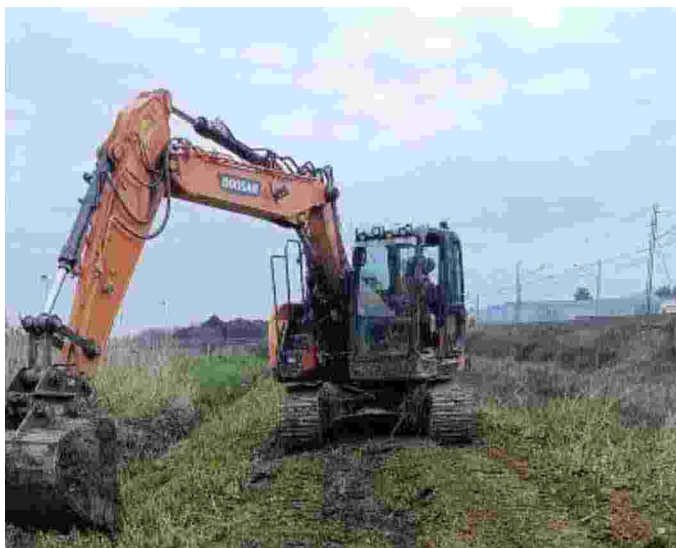
Ruspe già al lavoro per la pulizia dei fossi
