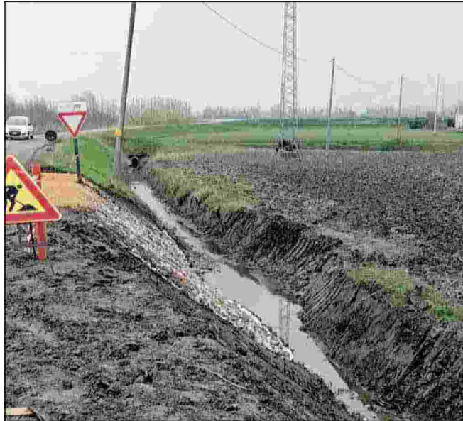
lavori di ripristino del tratto stradale
