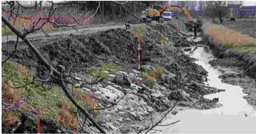
I lavori L'intervento in via Arginello Schiappa durerà due settimane
