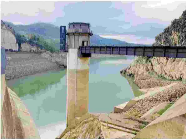
La diga Jato. Impianto gestito dal Consorzio di bonifica Palermo 2
