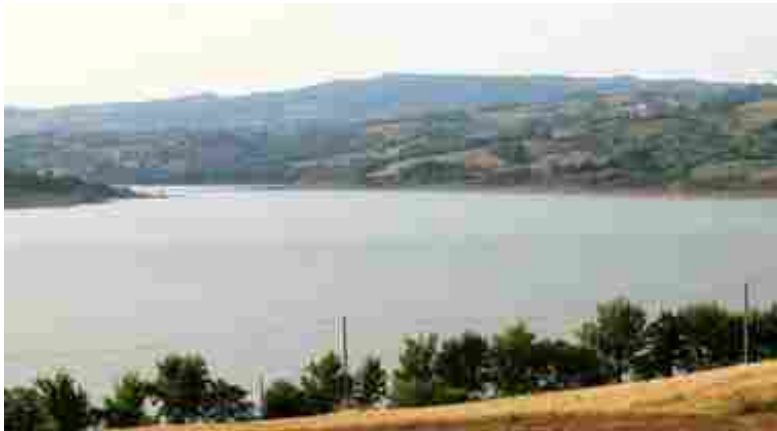
Diga di Campolattaro, partono i lavori
