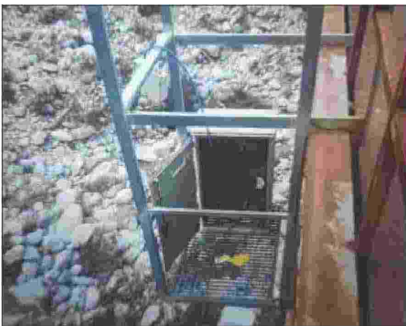
Il partitore sul fiume Soleo
