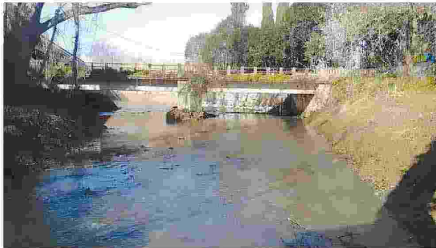
Due immagini dei lavori terminati lungo il torrente Corese
