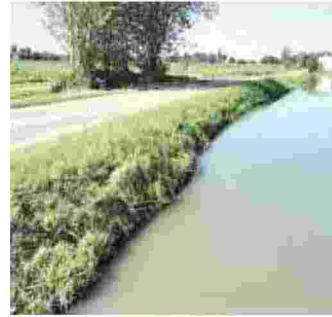
I lavori sono a cura del Consorzio di Bonifica di Ferrara
