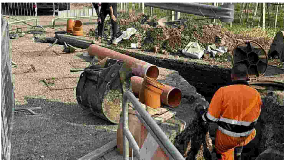
Il cantiere di Acque Veronesi a Isola Rizza
