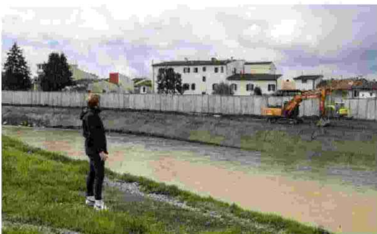
L'intervento nella zona di Santa Maria dopo i danni causati dall'alluvione nel novembre del 2023 (FotocronacheGermogli)
