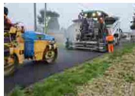
Proseguono le asfaltature a Copparo
