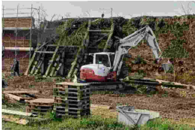
Il cantiere I lavori sono ricominciati a pieno regime
