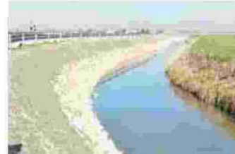
I lavori di ripresa spondale a Pontelagoscuro del Consorzio di Bonifica
