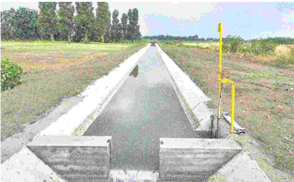
BONIFICA Sono stati rifatti dei tratti di canalette irrigue nel territorio dell'Isola di Ariano
