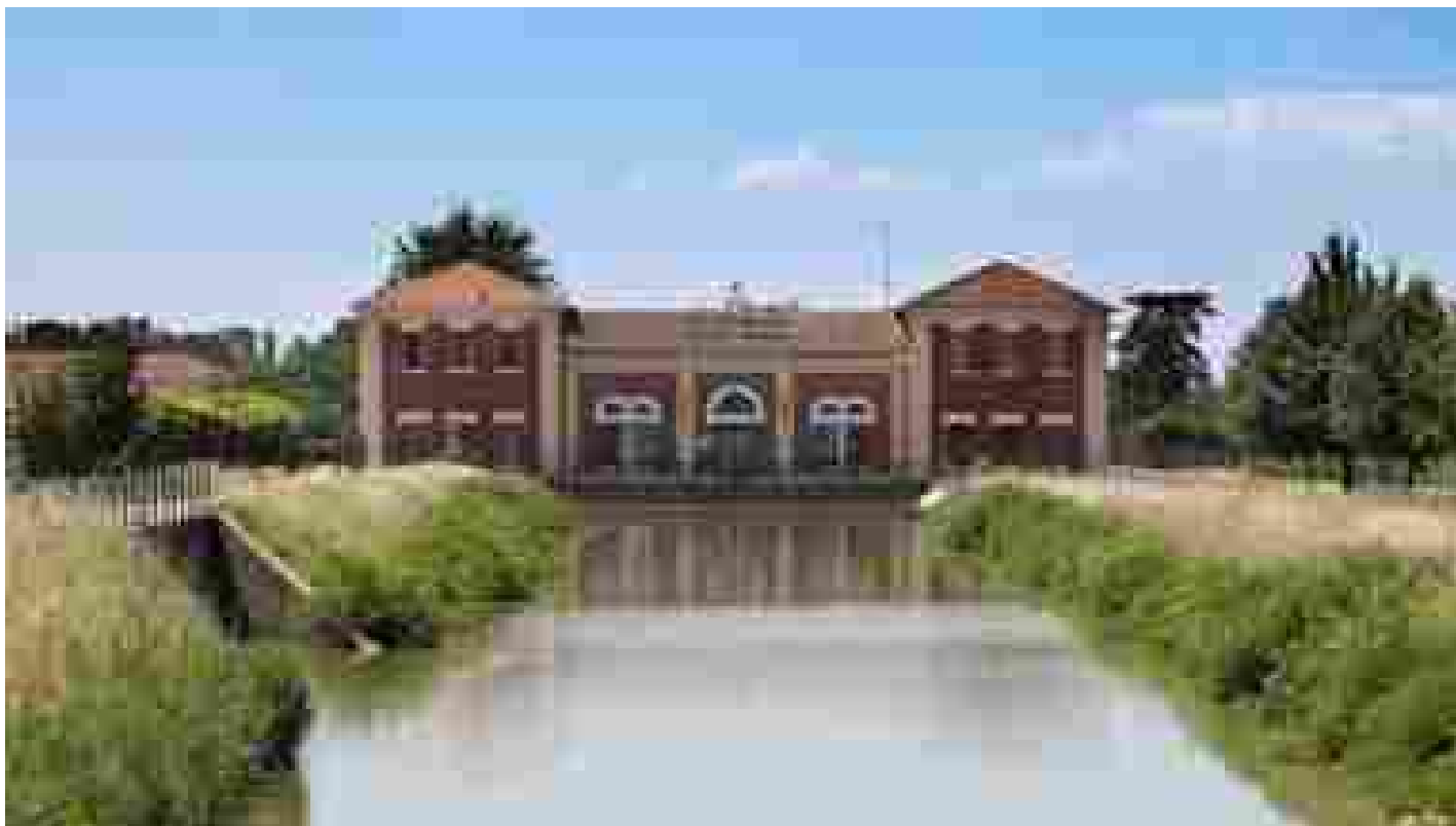
L'impianto di Cona
