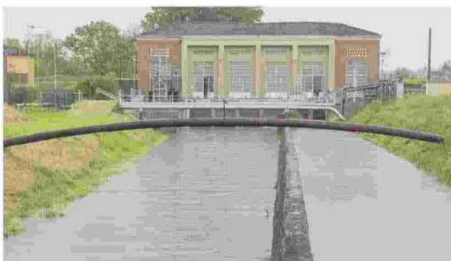
L'impianto idrovoro della Finarda a Piacenza
