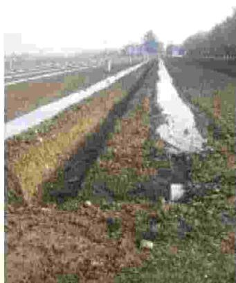
Canali di infiltrazione
