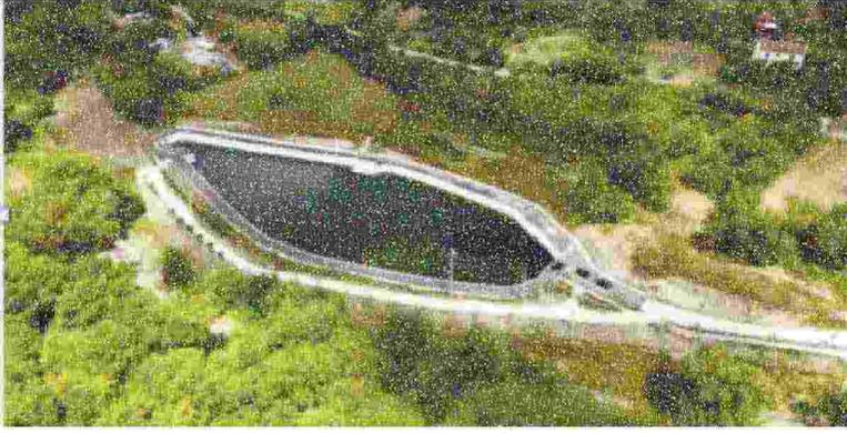
Vasca di accumulo della capacità di 41.000 mc realizzata nell'ambito dei lavori di interconnessione degli schemi idraulici del Torrente San Nicola e Macchioni
