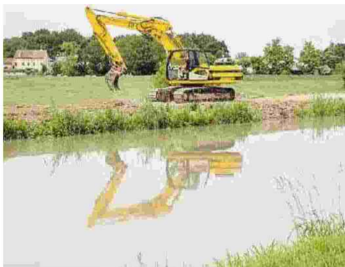
L'intervento di messa in sicurezza dell'argine dopo il crollo
