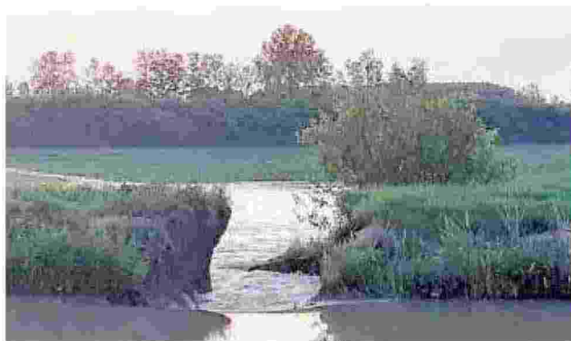
Il cedimento dell'argine e in alto i lavori di sistemazione di ieri DI GANGI
