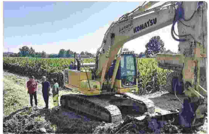
I lavori, in questa fase, stanno interessando il rio di Ponzano
