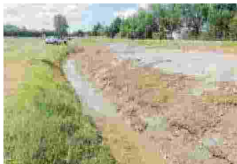
Il canale Vene dopo i lavori
