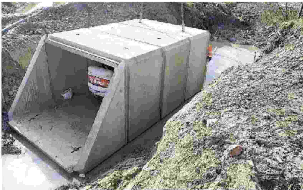
I lavori di ricostruzione del ponte sul canale Fossa Luzzarese in via Valbrina a Luzzara
