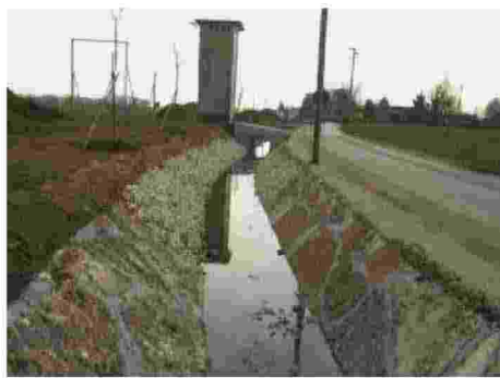
Le scarpate rivestite in pietra e le piante sul lato campagna
