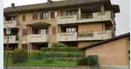
Appartamenti Cerro al Lambro Riozzo - Via dei Fiori
