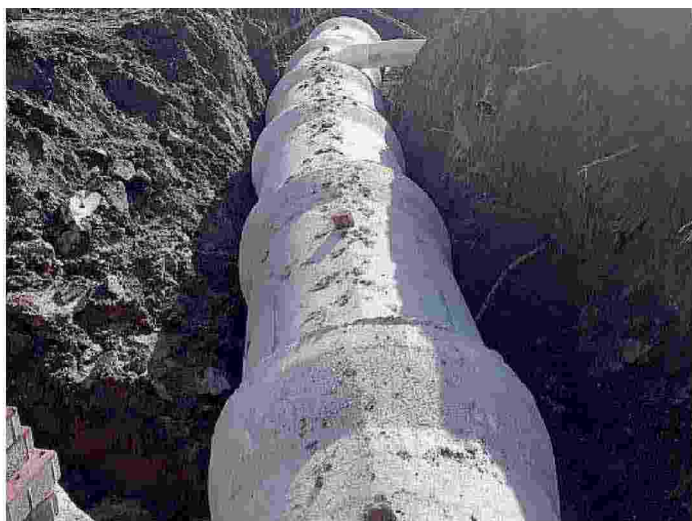
Il canale intubato che è stato oggetto dell'intervento di ripristino
