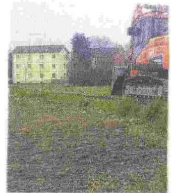
Lavori in via Bodrio
