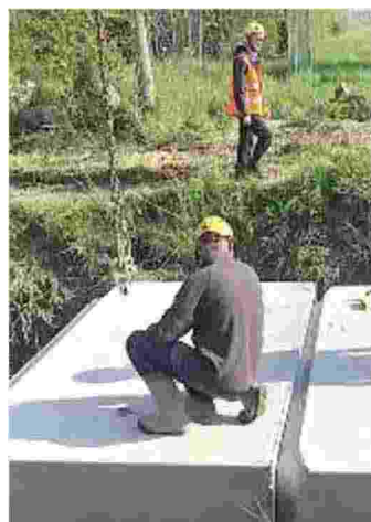
Gli operai impegnati
