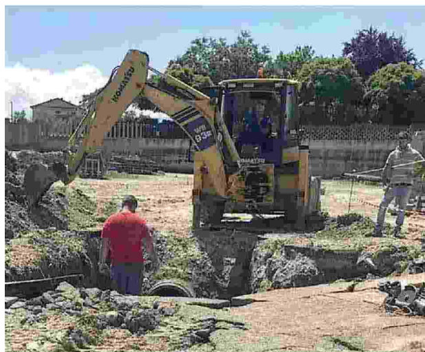
Operai al lavoro per la riparazione della condotta
