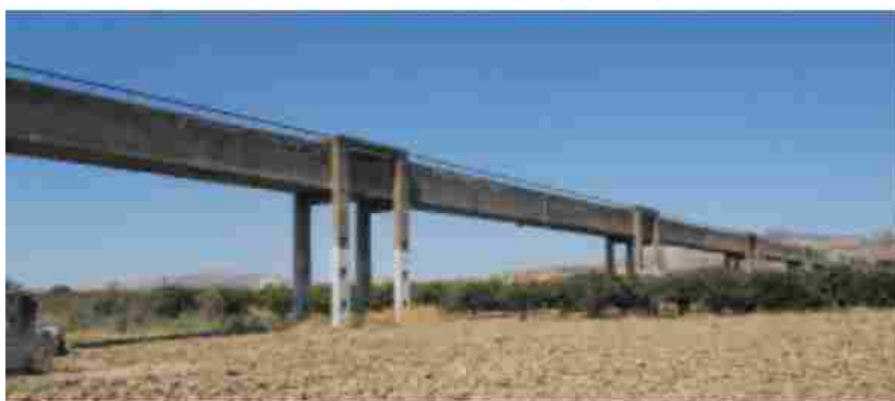
Fotografia 2 - Ponte canale a travate contrapposte.
