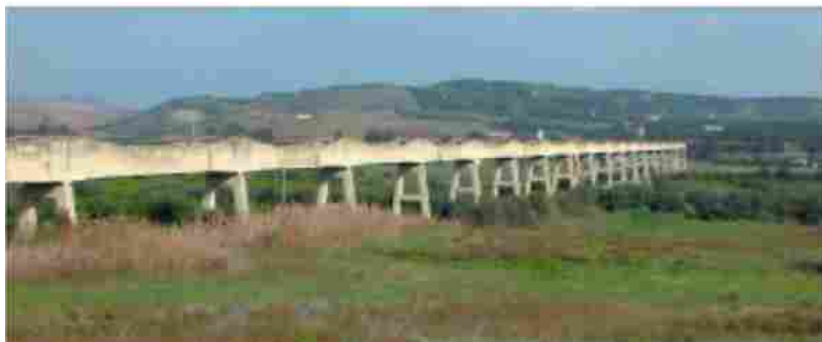
Fotografia 1 – Ponte canale a travate isostatiche tipo Gerber.
