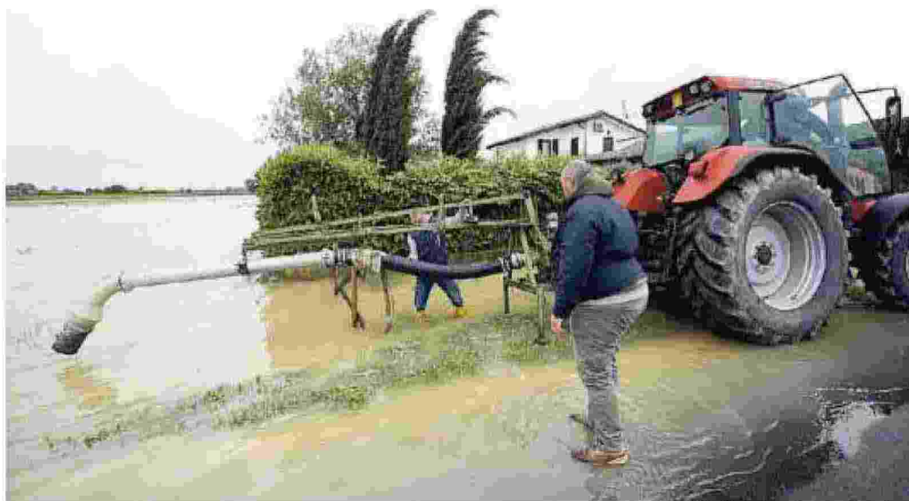
Uno degli allagamenti nella nostra provincia. Nello specifico la rottura di un argine
