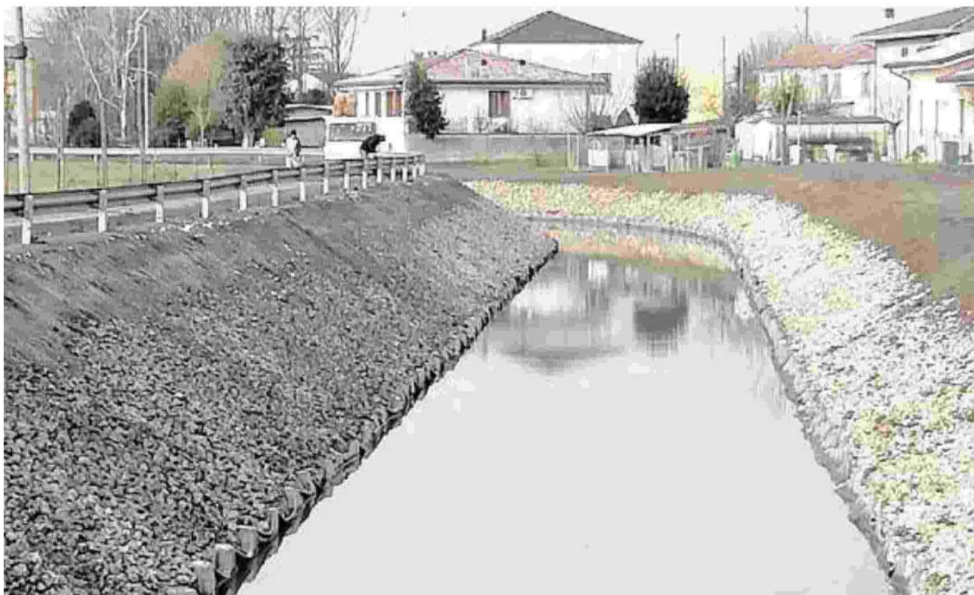
CONSORZIO DI BONIFICA Il restyling del Ceresolo punta a migliorare l'irrigazione dei campi e a prevenire eventuali allagamenti
